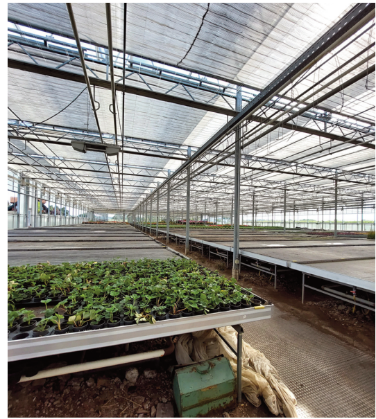
Zum Betrieb gehört unter anderem eine moderne Cabrio-Halle, deren Dach geöffnet werden kann. Die Dachelemente fahren dann zusammen – ähnlich wie bei einer Ziehharmonika.
