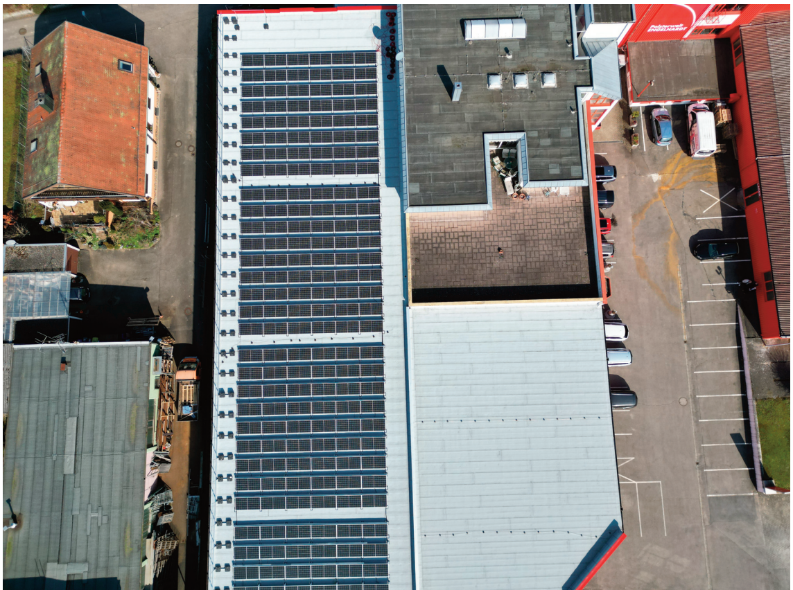
Ansicht auf die PV-Anlage mit 81,2 kWp
